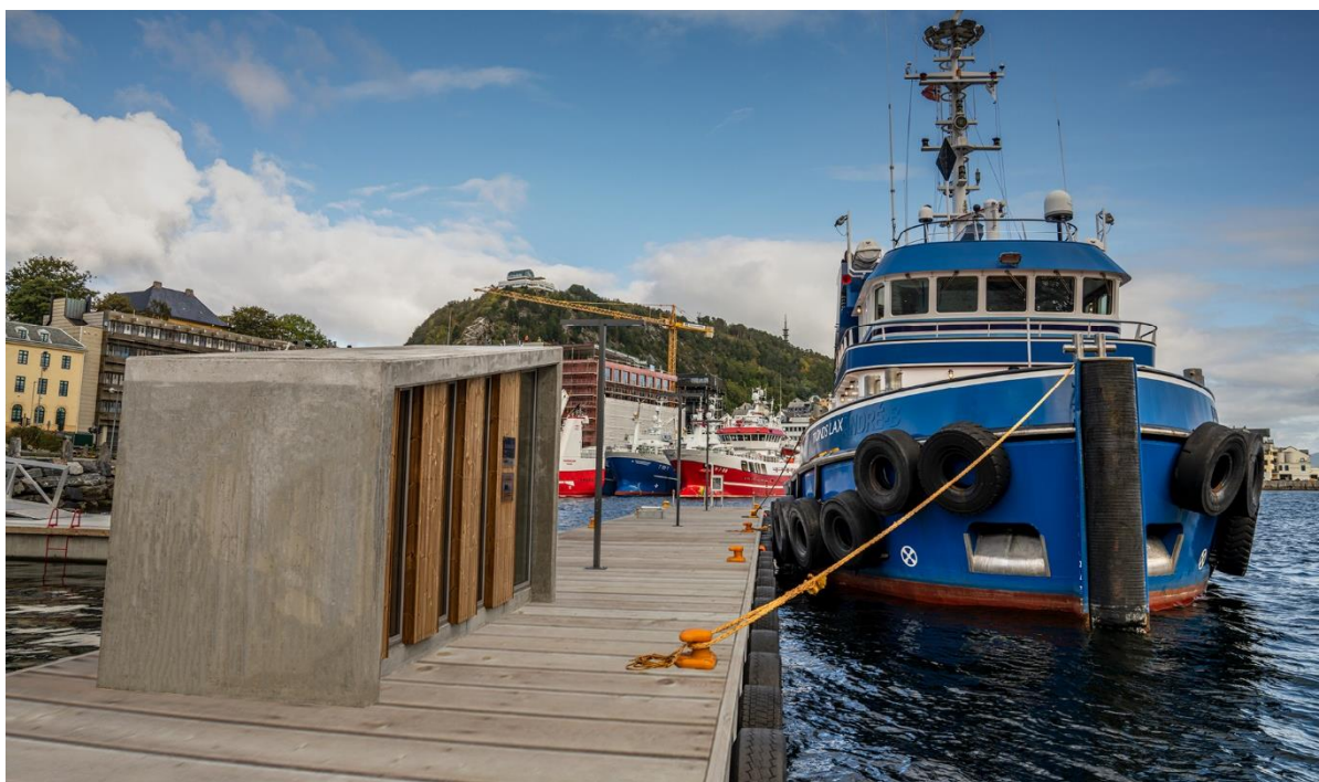
Figur 35 Illustrasjon av kai i Ålesund, med tredekke ala Bryggen (Marine Solutions AS/Rambøll)
