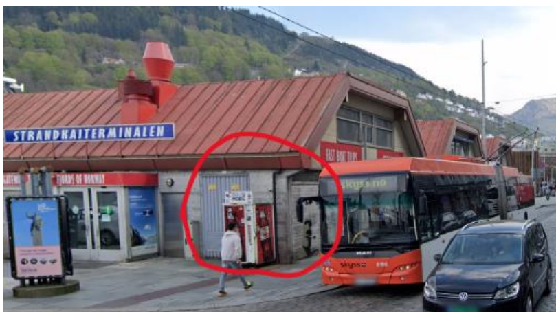
Figur 20 Eksisterende nettstasjon på Strandkaaien er integrert i terminalbygget
