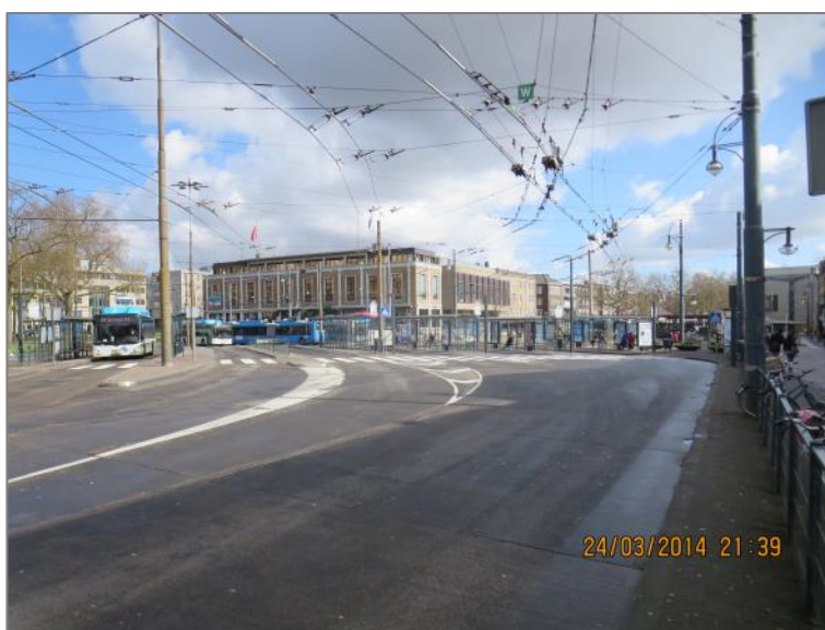
Figur 10. Trolleybussystemer trenger mye infrastruktur i luften, spesielt ved terminaler.
