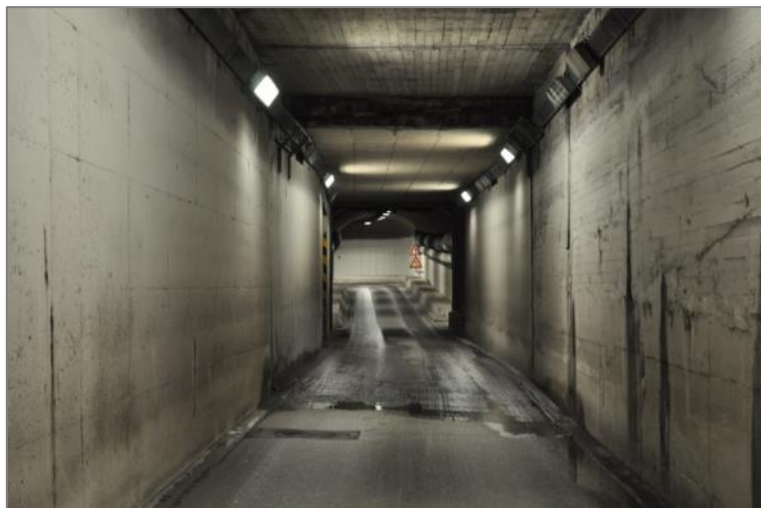
Figur 18. Sydnestunnelen er til dels trang og høyden er på minimumsnivå
