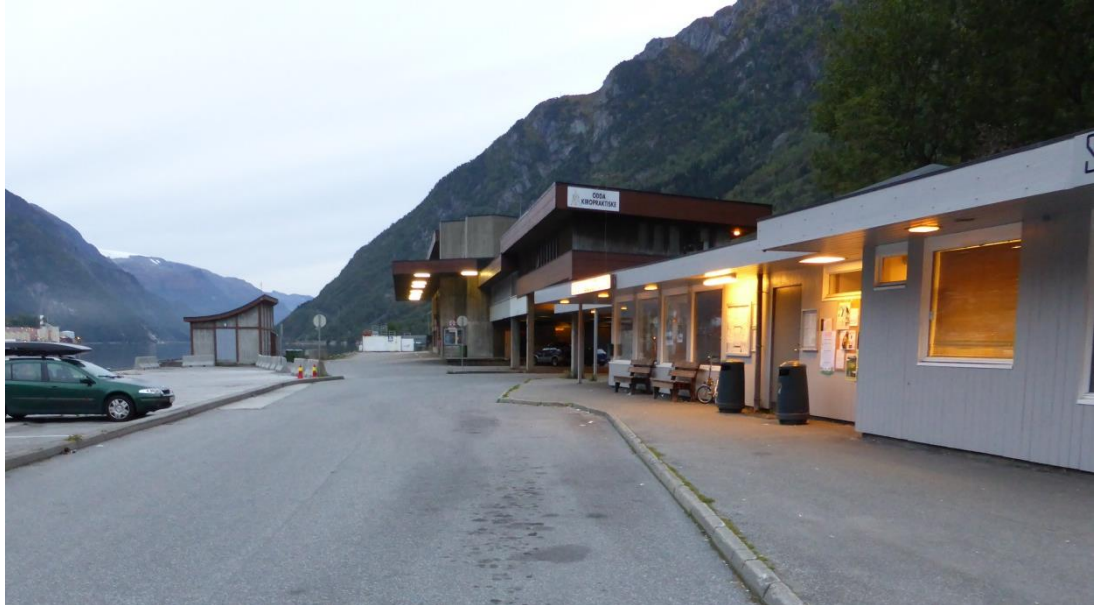
Figur 16 Odda busstasjon. Kaia til venstre i bildet.
