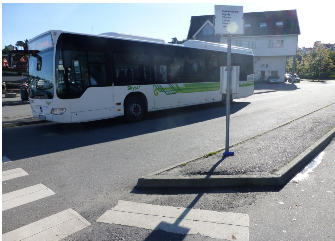
Figure 6 Leirvik knutepunkt. Smale refuger og høye plattformkanter.
